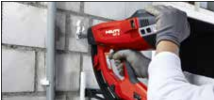
Fijación de tuberías ligeras y conduits
